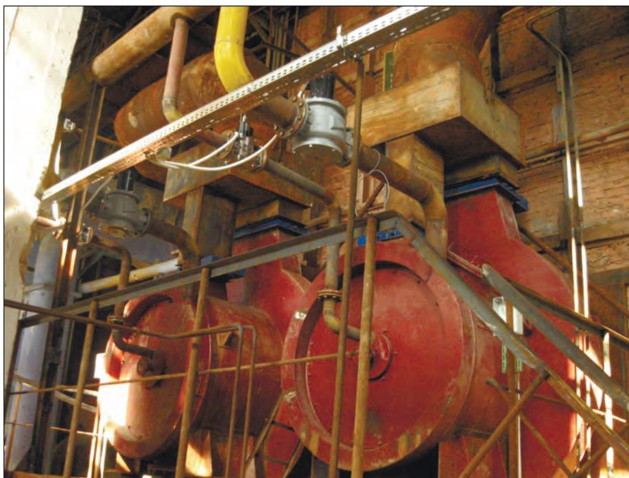
Газо-водоугольные горелки муфельного типа
