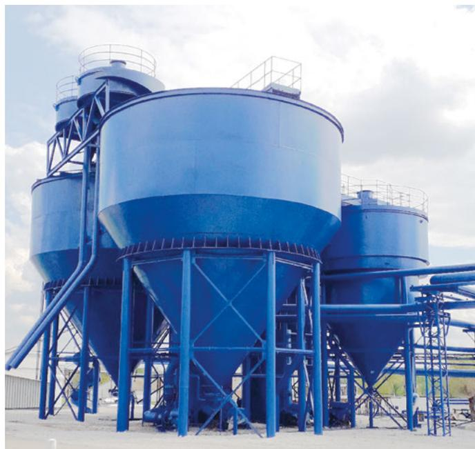
*Рис. 7. Установка для очистки и осветления транспортёрно-моечной воды*
